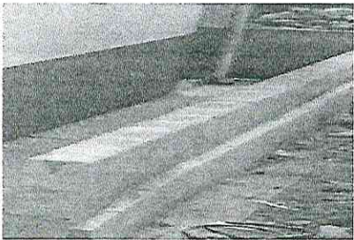
Foto 3: Reparación de canales de concreto para conducción superficial de agua pluvial, con pendiente y refuerzo.
